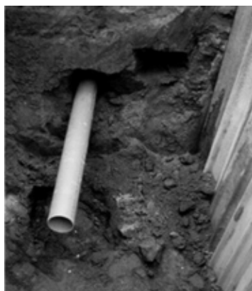
88. ábra: KG PVC házi bekötőcsatorna építése átfúrással
