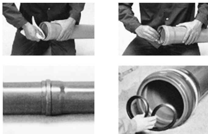
77. ábra: Tokos csőkötés elkészítésének főbb munkafázisai:
