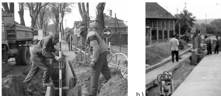
a.) 83. ábra: Folyamatos építés nagytáblás dúcolással a.) csőszerelés dúcolat védelme alatt, b.) szalagszerű építésszervezés nagytáblás dúcolattal
